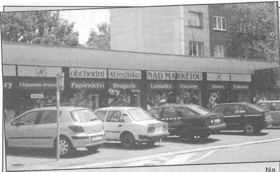
Na Petřínách známé Obchodní středisko Nad Markétou ukončilo prodejní činnost a bude zbouráno. Na jeho místě vyrostě polyfunkční dům.
