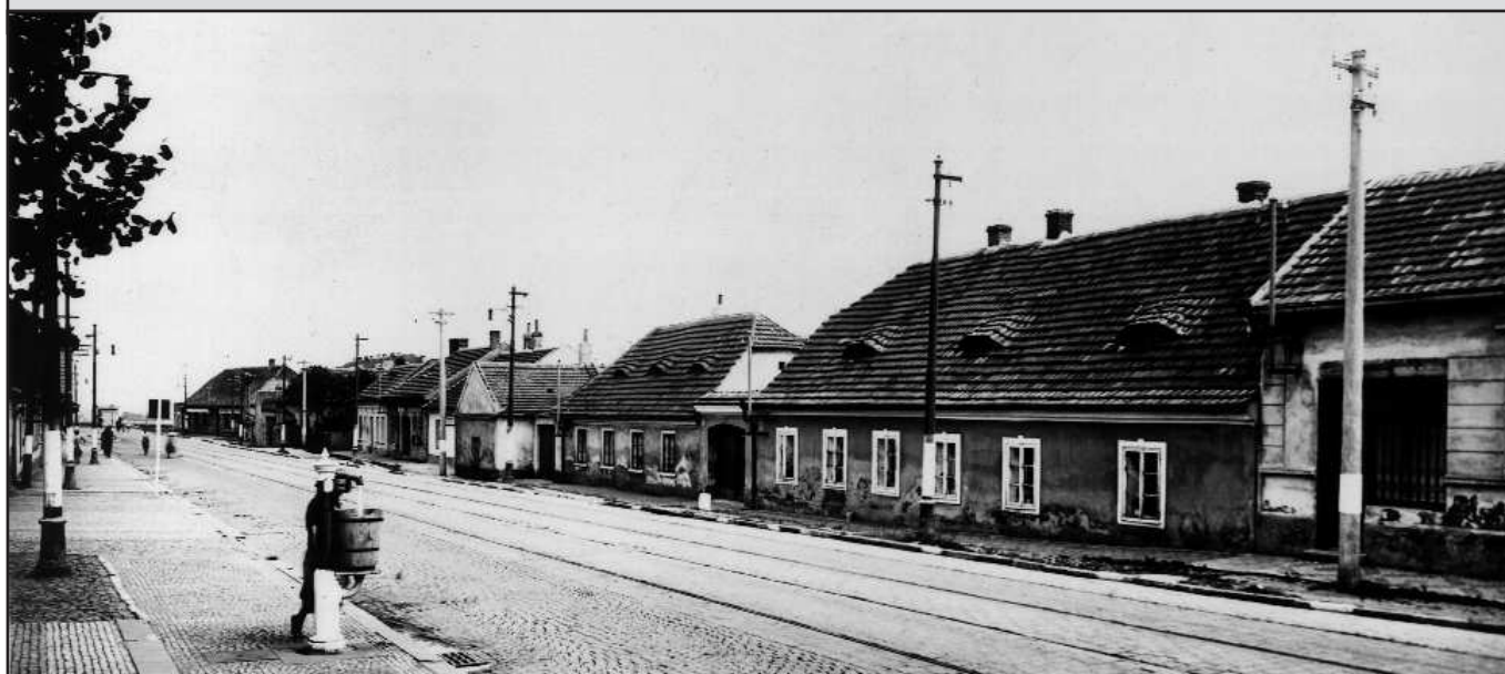
Výrobci slavných sýrů zvaných Čapčoch bydleli na Bělohorské v Malém Břevnově. Na prvním snímku (domy jsou před demolicí) je v pozadí zvonička a v prvním domě zprava za sloupem bydleli Čermákovci. Na spodním obrázku z 1. rep. z protilehlé strany do chodníku vyčnívá Pletichovic stavení. Zde by dodnes měl být velmi hluboký sklep.
